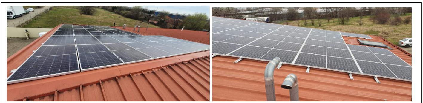
12,1 kW teljesítményű napelemes rendszer
